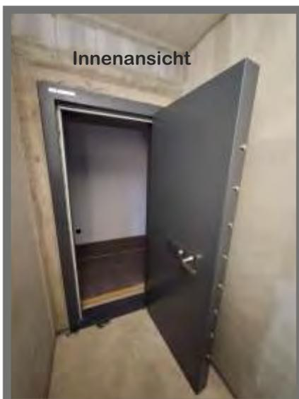
**Einbau einer neuen qualifizierten Innenwand in modularer Bauweise gleichwertig Widerstandsgrad I (1) nach EN 1143-1**
