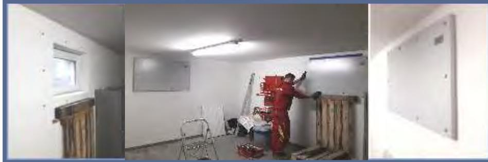
**Wandelement** zur massiven Absicherung von im Raum befindlichen Fenstern und anderen größeren Öffnungen. Die Montage erfolgt durch Wandverankerung des Moduls mit 10 Spezialverankerungen im Mauerwerk oder in der Betonwand.
